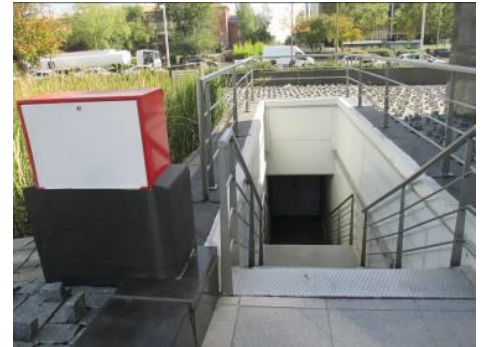
Figure 8 - débouché de l'issue de secours au niveau de la rue
