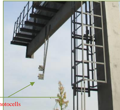
Figure 7- détection automatique de hors gabarit
