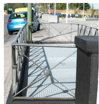
Figure 11 - grille d'évacuation d'air vicié
