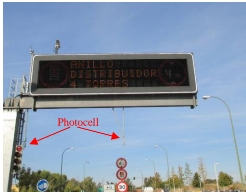
Figure 12 - panneau à messages variables en entrée de tunnel
