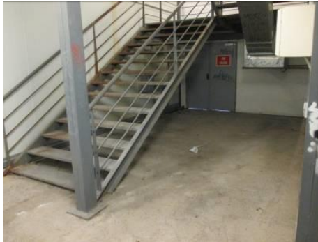
Figure 7 - escaliers métalliques d'évacuation
