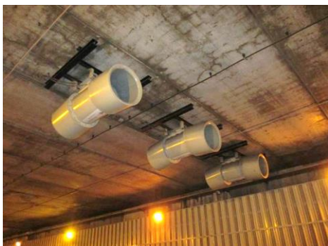
Figure 9 - accélérateurs en voûte
