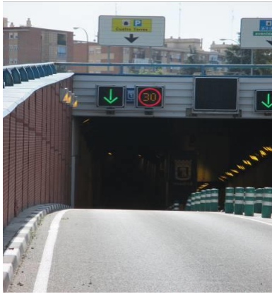
Figure 4 - accès Sud - rue Monforte de Lemos
