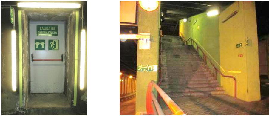
Figure 6 – porte d'issue de secours – rampe d'évacuation entre les deux niveaux
