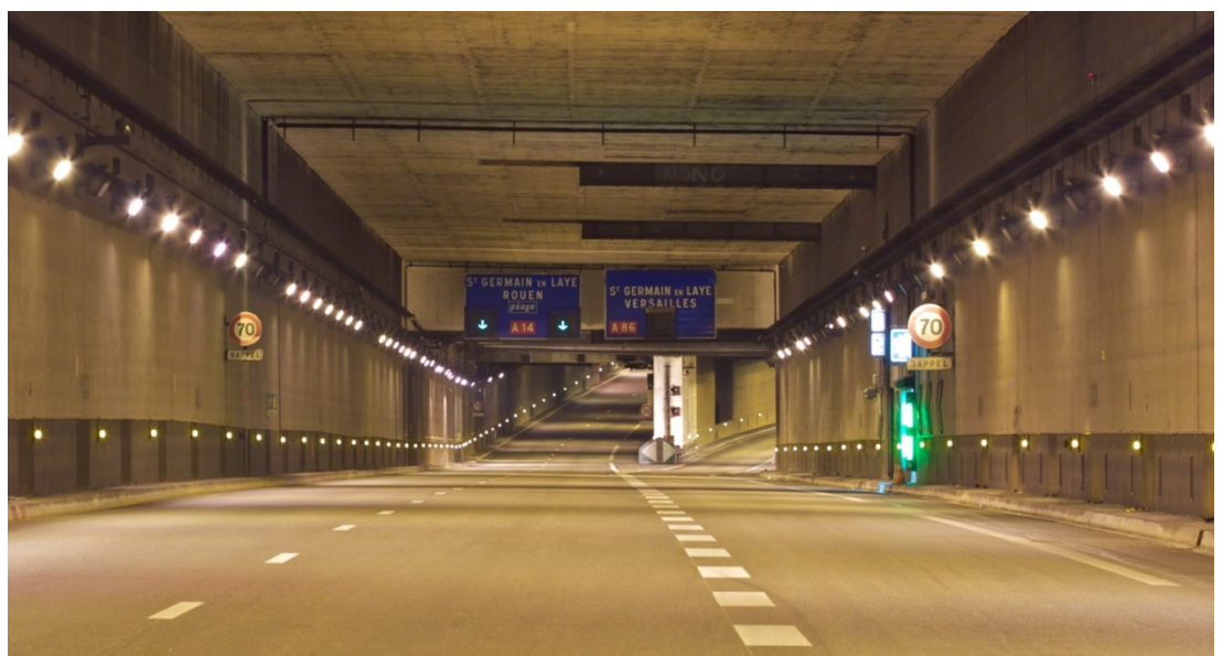
Figure 4 – échangeur autoroutier A14 / A86
