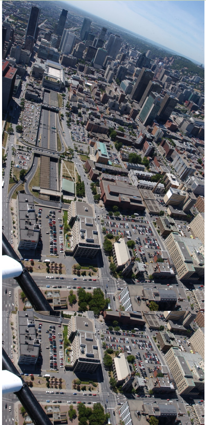
Figura 3 – Sector a cielo abierto entre el túnel Viger (abajo) y el túnel Ville-Marie (arriba)
