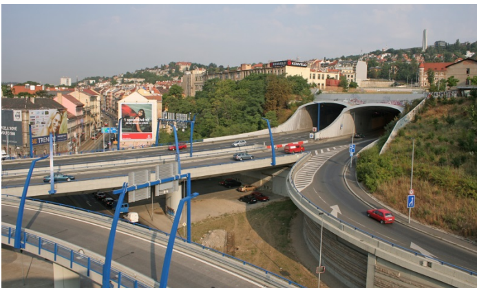
Figura 6 – Boca sur del túnel Strahov y vista del puente que da acceso al túnel Mrázovka
