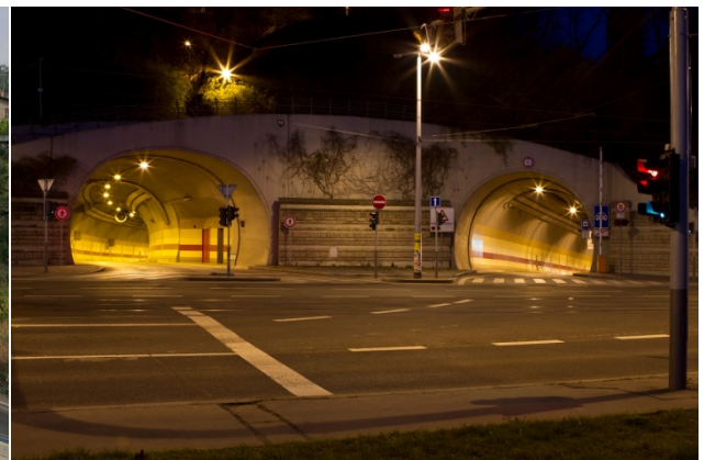
Figura 7 – Bocas de los ramales del acceso Suroeste al túnel Mrázovka y conexión con la calle Radlická
