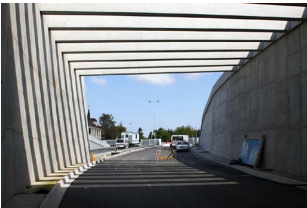
Figura 10 – Intersección en U de Vorlíkú, ramal 1 (Dejvice) – vista desde la boca
