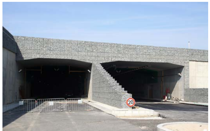
Figura 11 – Boca este del túnel del complejo Blanka (Bubeneč)
