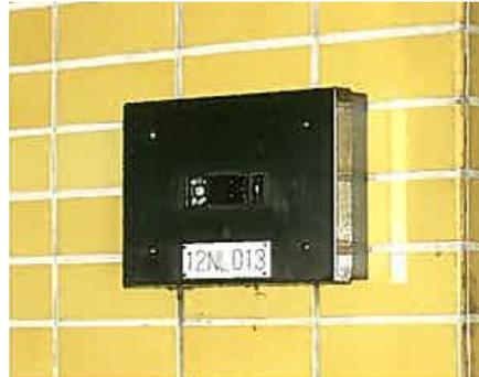
Figura 6 – Detector automático de incendio
