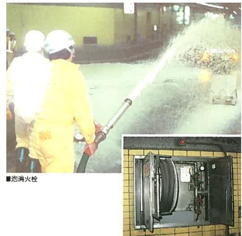
Figura 10 – Hidrante de espuma
