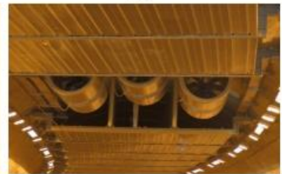
Figure 5 - vues de détail de la signalisation (a) - installations de ventilation au droit du diffuseur souterrain (b) - installation de ventilation et atténuateurs acoustiques (c)
