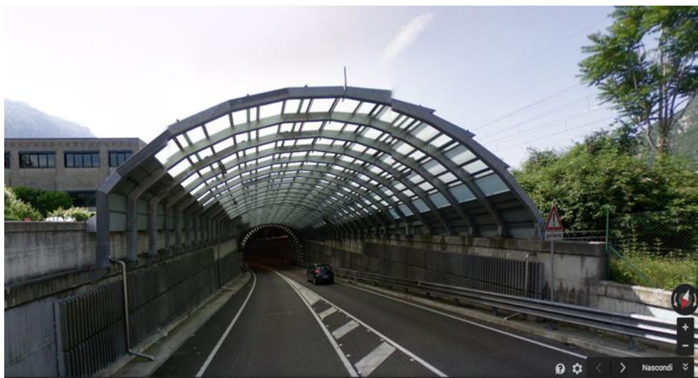
Figure 2 - tête de tunnel de Lecco
