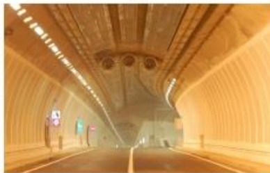
Figure 5 - vues de détail de la signalisation (a) - installations de ventilation au droit du diffuseur souterrain (b) - installation de ventilation et atténuateurs acoustiques (c)
