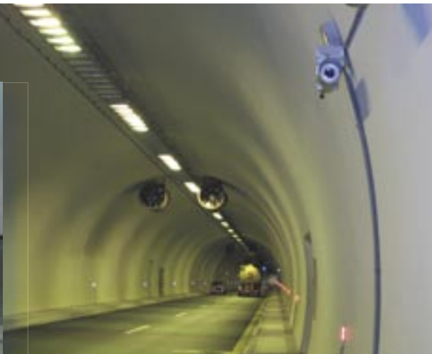
Figure 30 : éclairage permanent d'évacuation utilisé pour le guidage routier dans un tunnel espagnol
