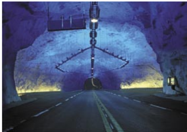
Figure 28 : intérieur d'un tunnel norvégien avec éclairage permettant de se repérer
