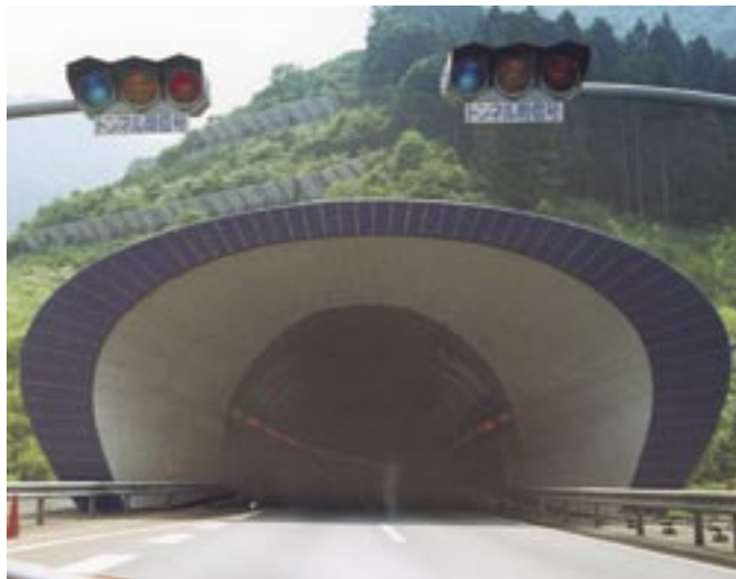
Figure 26 : tête du tunnel japonais de Kanetsu
